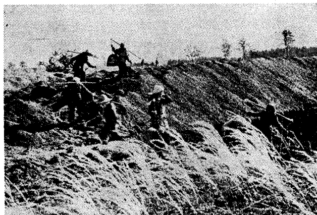
写真-3.2 人力によるぼら排除(鹿児島県農政部)
