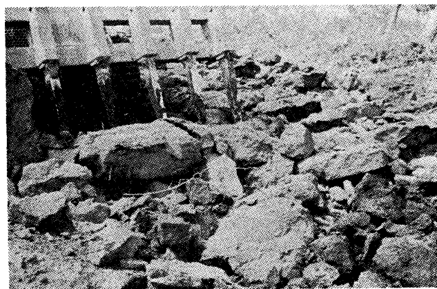
写真-3.3 レーキによるこら排除(鹿児島県農政部)
