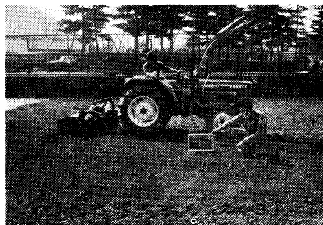
写真—8.4 表層工（掘起こし工）
