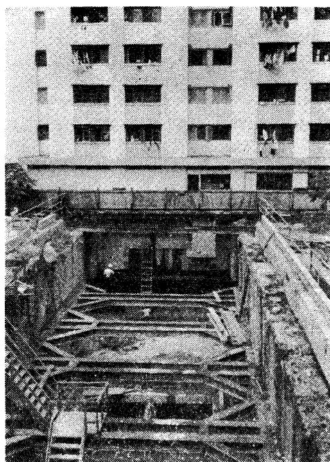
写真—4 シンガポール地下鉄建設工事（既設アパート直下を横断するトンネル）
