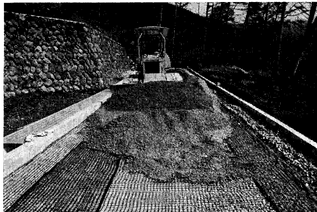
写真—4 合成樹脂網施工状況
