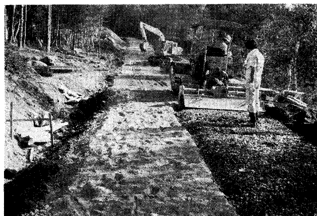
写真—3 セメント系安定処理施工状況
