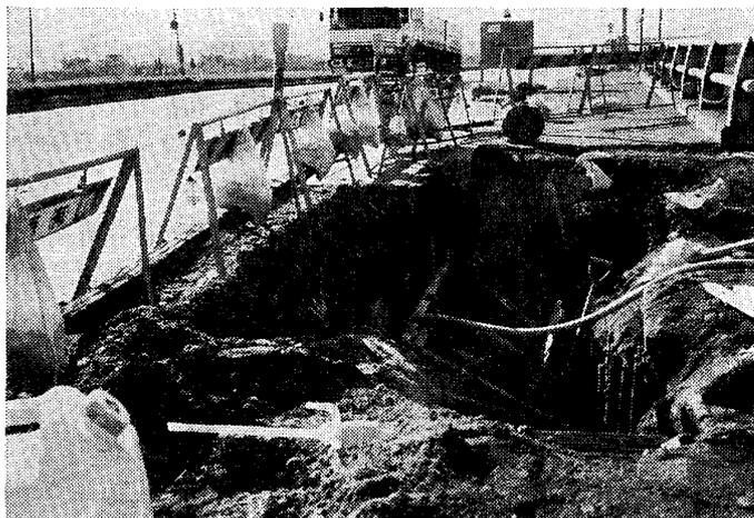
写真-3 空洞充填工事として気泡モルタル注入中
