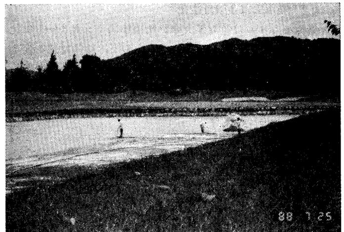
写真一2 ゴルフ場池改修工事での気泡モルタル施工中
