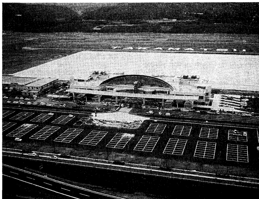
写真-2 新高松空港旅客ターミナルビル（平成元年10月撮影）
