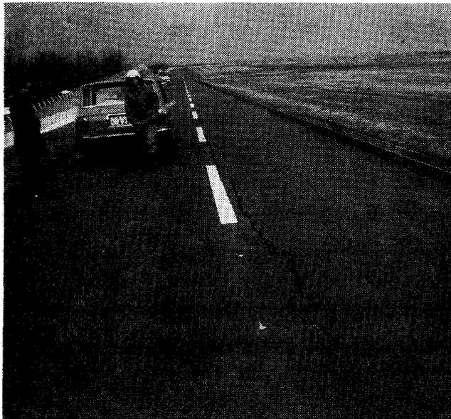
写真-7.2.1 凍上による舗装のクラック
