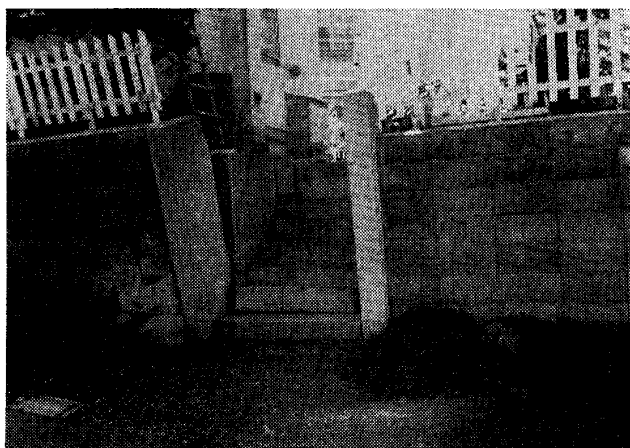
写真—7.4.3 凍結膨脹圧（横凍上）による簡易な擁壁の傾斜（昭和40年代後期）
