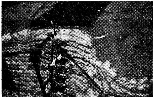
写真—2 5分のり面崩壊時の補強部の状況
