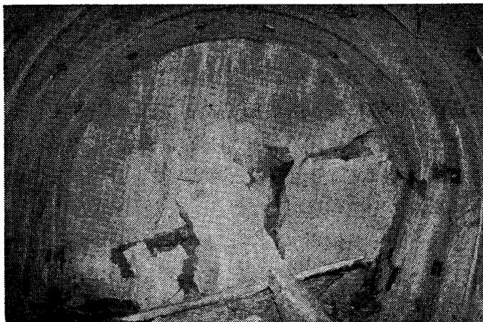
写真-1 断層破砕帯での作業坑変状
