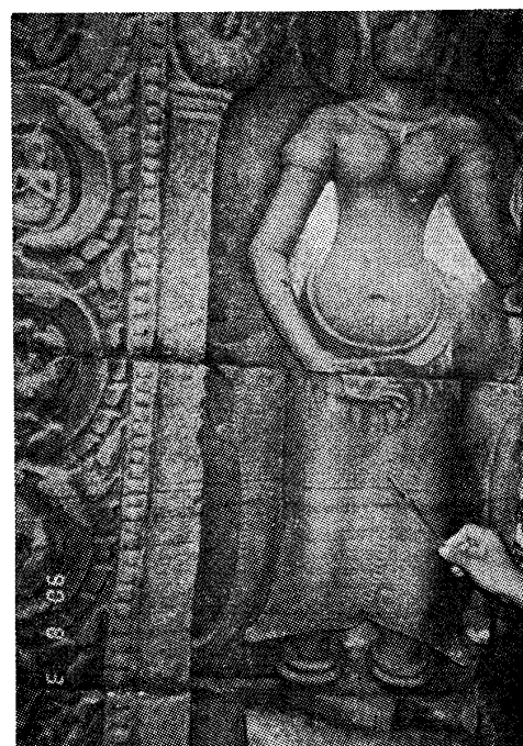
写真-3 バンテアイ・クデイの砂岩中の層理
