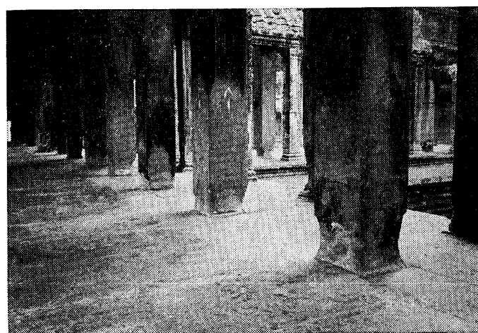
写真-2 アンコール・ワットの柱脚部の侵食現象
