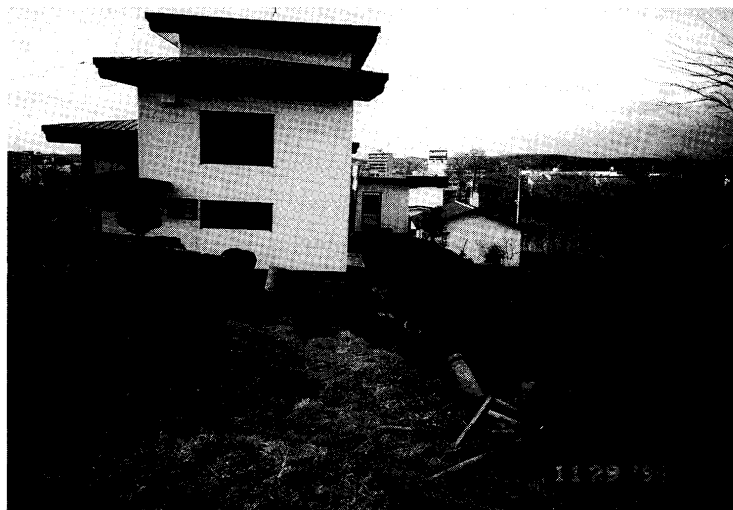
写真-1 中標津町造成盛土の崩壊
