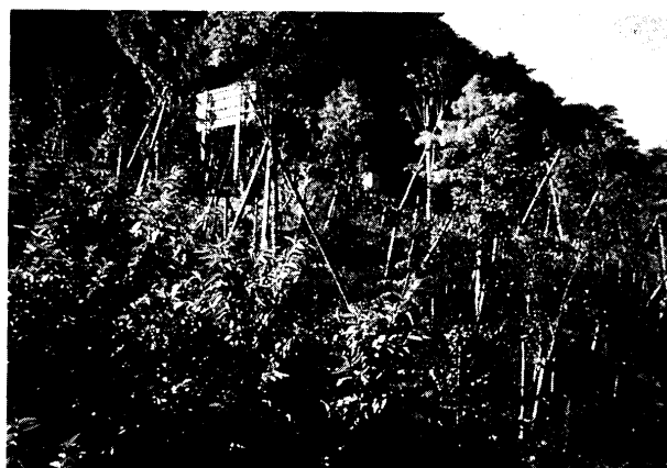
図-4 周辺と調和した法面植栽（日光宇都宮道路）
