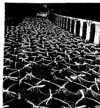
写真-6.1 構築中のPneusol（プノソル）の壁
