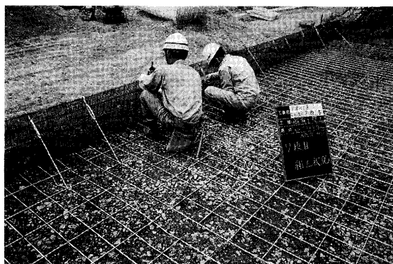
写真二 階段状補強盛土部材の組立て
