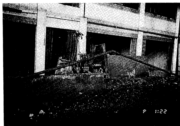
写真—4.1 ルソン島地震ダグパン市内の埋設管圧壊現象
