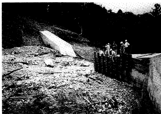
写真—8.3 西之貝戸川 土石流の流下をくい止めた砂防ダム
