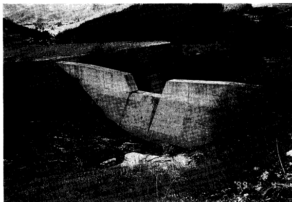
写真—8.4 白猪谷 土石流発生前
