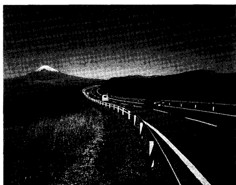
写真—6.1 地形に沿った線形設計による地形秩序の保全 (伊豆スカイライン)
