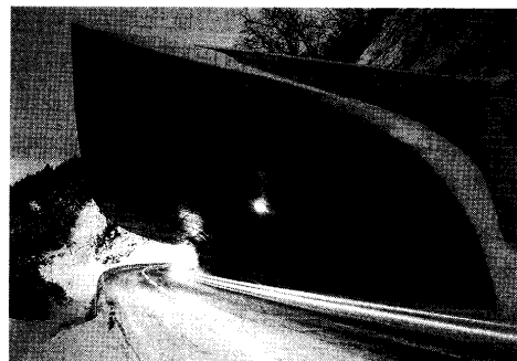
写真—6.15 片持ち構造の覆道。除雪の便と除雪を考慮した形態。〈北海道 R230・仙境覆道；昭和47年、開通当時〉
