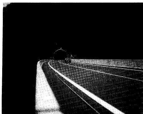
写真—6.5 自然環境の保全のために当初案の高い切盛土をトンネルと橋梁で代替（日光宇都宮道路）
