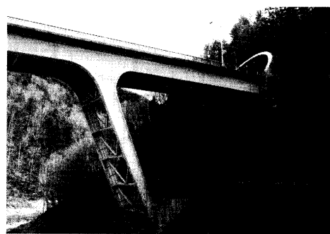
写真—6.11 ラーメン橋台の上に突出部のアーチ型フードを乗せ、構造物を最小化した例。〈北海道 R273・不二川橋と不二川トンネル〉
