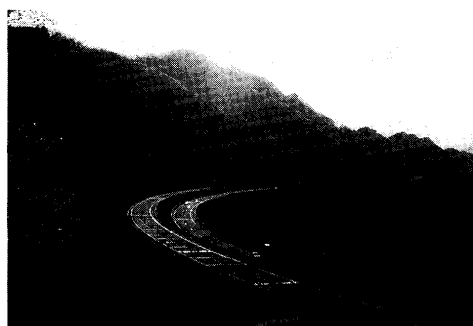
写真—6.2 地形改変を抑えるために採用された高架構造 (山形自動車道)
