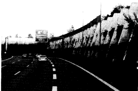
写真—6.14 バットレスの反復効果が効いている擁壁。 〈ドイツ・デュッセルドルフ〉
