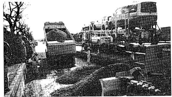
図-4 適用事例 (一般道下層路盤材)
