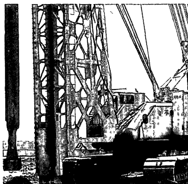
写真一 振動棒工法施工機械
