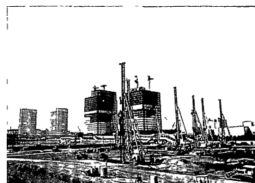
写真一 幕張新都心の施工状況
