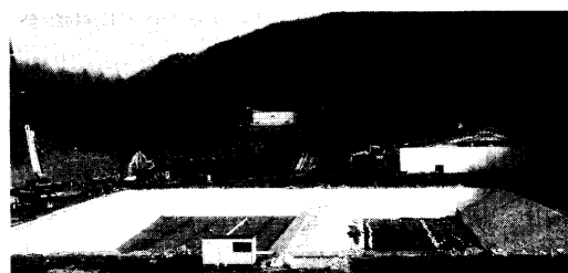
写真—1 浸出水貯留池
