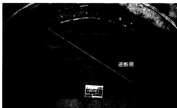
写真-1 中央導坑切羽に出現した逆断層
