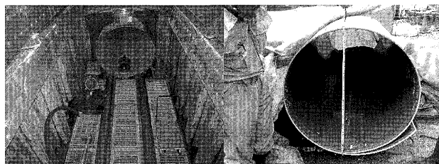
写真—1 鋼管挿入ピット
