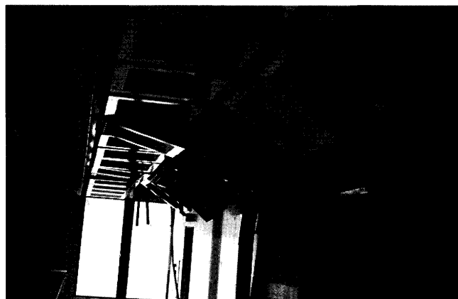
図 7 制御棟ロビー（天井板の落下）。
