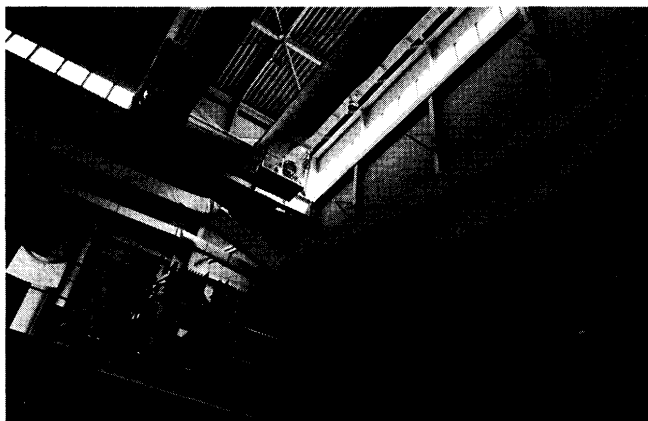
図 4 超伝導コイル開発建屋（天井に設置されていた空調機器の落下）。
