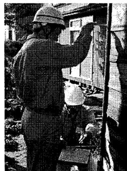
図3 手製の下げ振りによる傾斜測定
