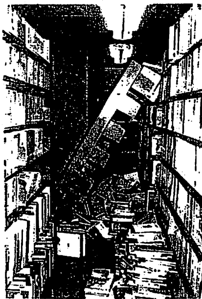
写真2 倒れかかった書架 釧路市立図書館撮影
