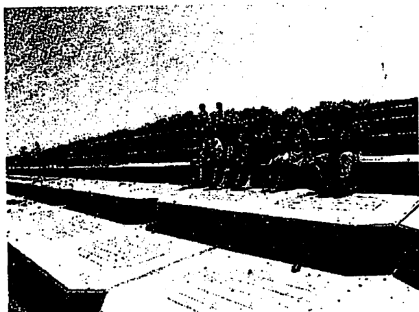
写真-2 海水浴客等が迅速に海岸から避難できるよう階段状になっている海岸堤防。ベンチ代わりにも活用される。 (清水市真崎海水浴場)
