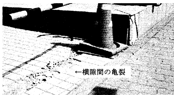
写真-2 亀裂の状況
