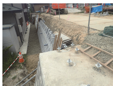
(1) 固結材盛土工+ブロック積み擁壁の例
