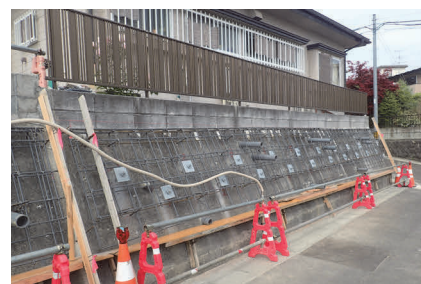
施工中 (鉄筋の長さは不明)
