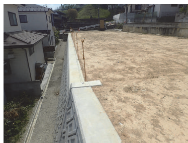
(1) 固結材盛土工+ブロック積み擁壁の例
