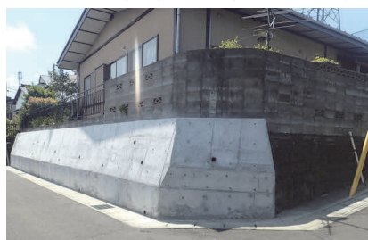
施工後(施工中とは別の住宅)
