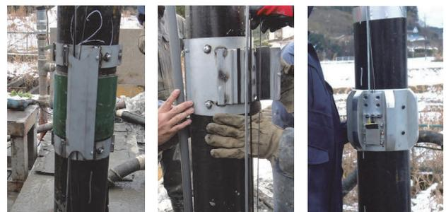
図-2 光ファイバーの取付け方法
