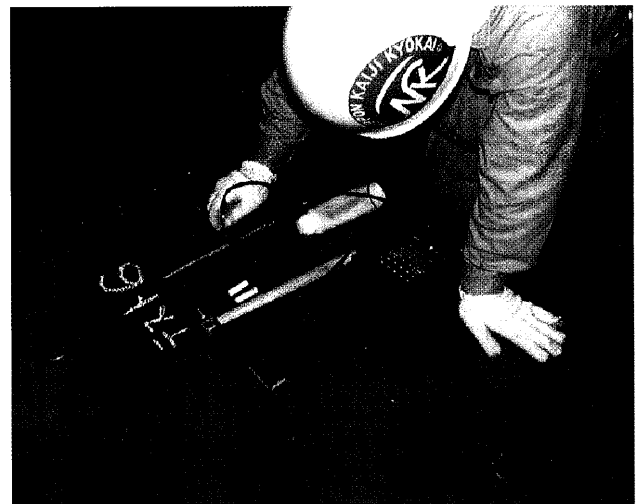
(a) 板厚計測位置・計測状況（テスト5） A.P.Tk 右舷側 W.B. マンホール付近
