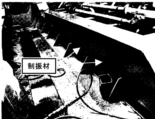
図5 主機台ガードへの制振材施工例 1)
