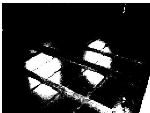
図4 床への制振材施工例 1)
