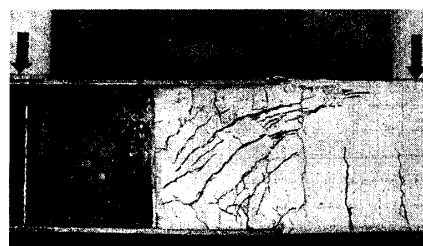
図7 Aタイプ接合部の破壊状況
