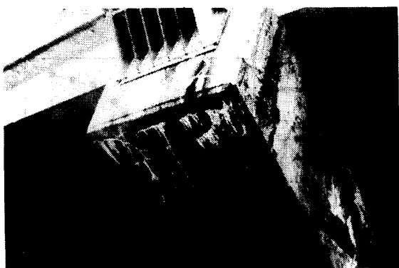
写真-3 梁端部の劣化状況(E橋)
