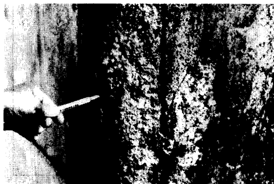
写真-2 梁表面部の変状(C橋)
