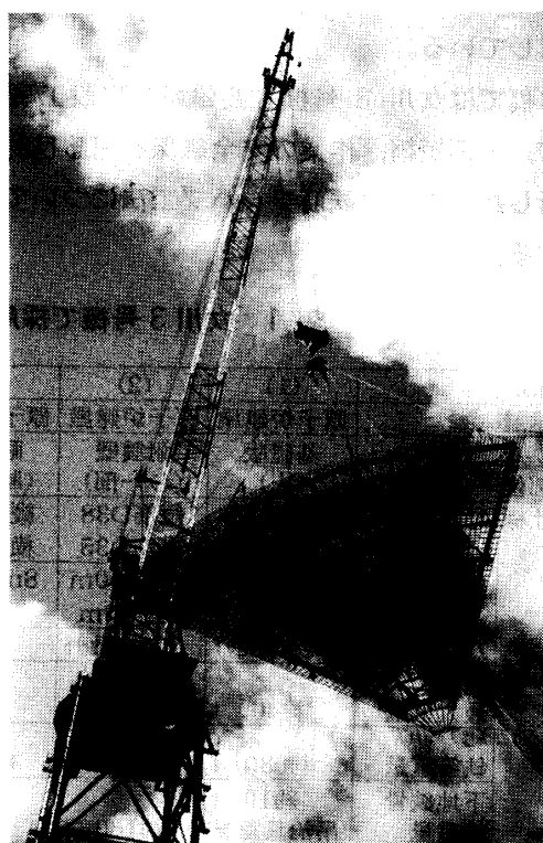
写真-1 基礎版プレハブ吊り込み状況
