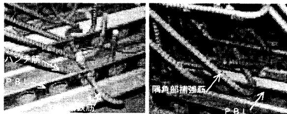
写真-1 ハンチ筋・隅角部補強筋結合状況
