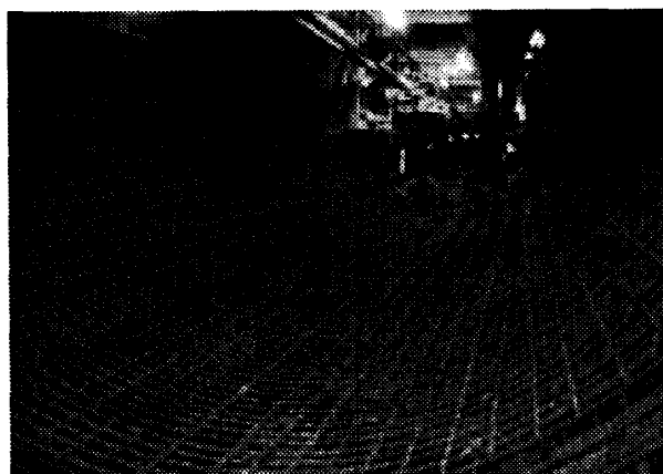
写真－１ 配筋状況
