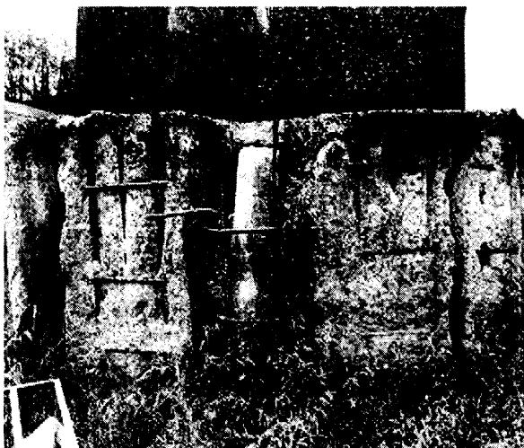
写真-6 e 橋梁橋脚基礎
