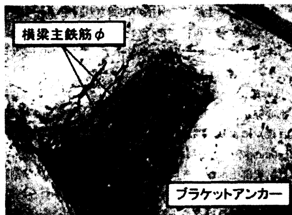
写真-2 主鉄筋切断状況
