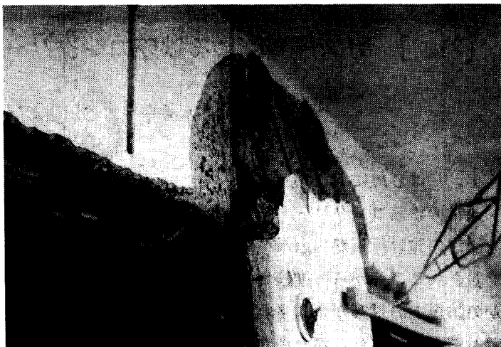
写真-1 バルコニー側壁上部のコンクリート剥離状況及びアルミサッシュと周囲の枠材がガラスとともに飛散した状況
