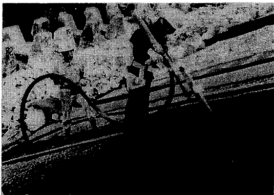
写真-3 薄層客土の吹付け状況
