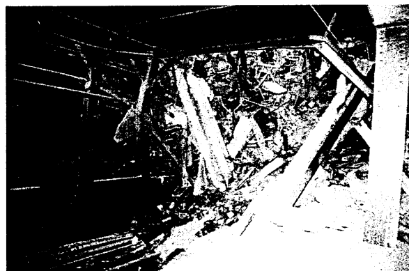
Fig.5 市地下鉄①⑨号線の被害
