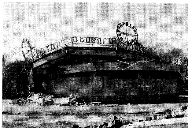
写真-3 スピタク市河川敷付近にある2階建 レストランの崩壊
