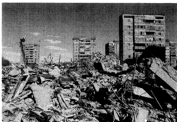
写真-4 レニナカン市北部のアパート群の崩壊
