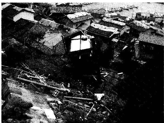
写真2 玄界島の家屋倒壊状況
