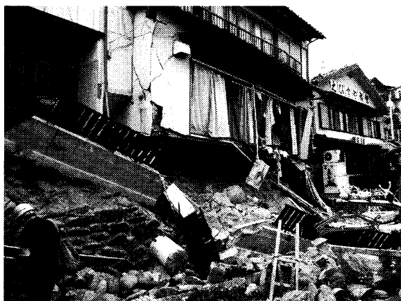
写真1 玄界島の宅地被害状況
