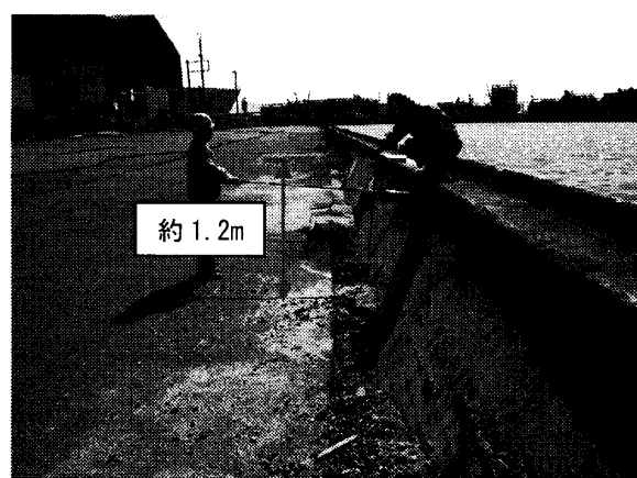
写真 5 中央埠頭の護岸のせり出し
