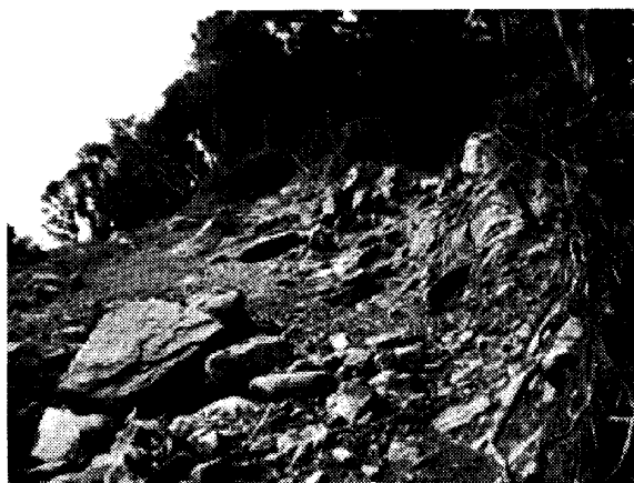
写真3 遷急線付近にみられる崩壊（玄武岩の節理に沿った崩壊）
