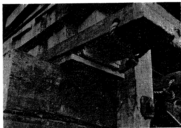
写真4 Load Cell 装置を Fore Poppet の 盤木の間に入れる.
