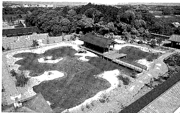
図-4 復原整備後の全景(東南より西北方向を望む)
