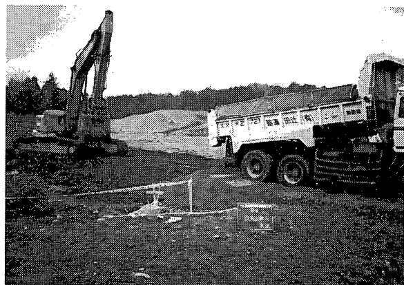
写真—5 混合土の盛土
