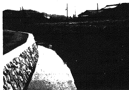
写真1 整備された水路
