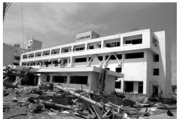
写真4 宮城県南三陸町の4階建ての鉄筋コンクリートビルの被災状況
