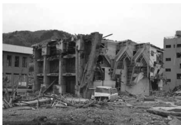
写真1 宮城県女川町における倒壊した鉄筋コンクリートビル
