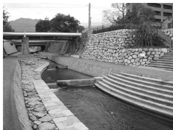
写真-1 死者5人が発生した神戸市・都賀川の親水空間
